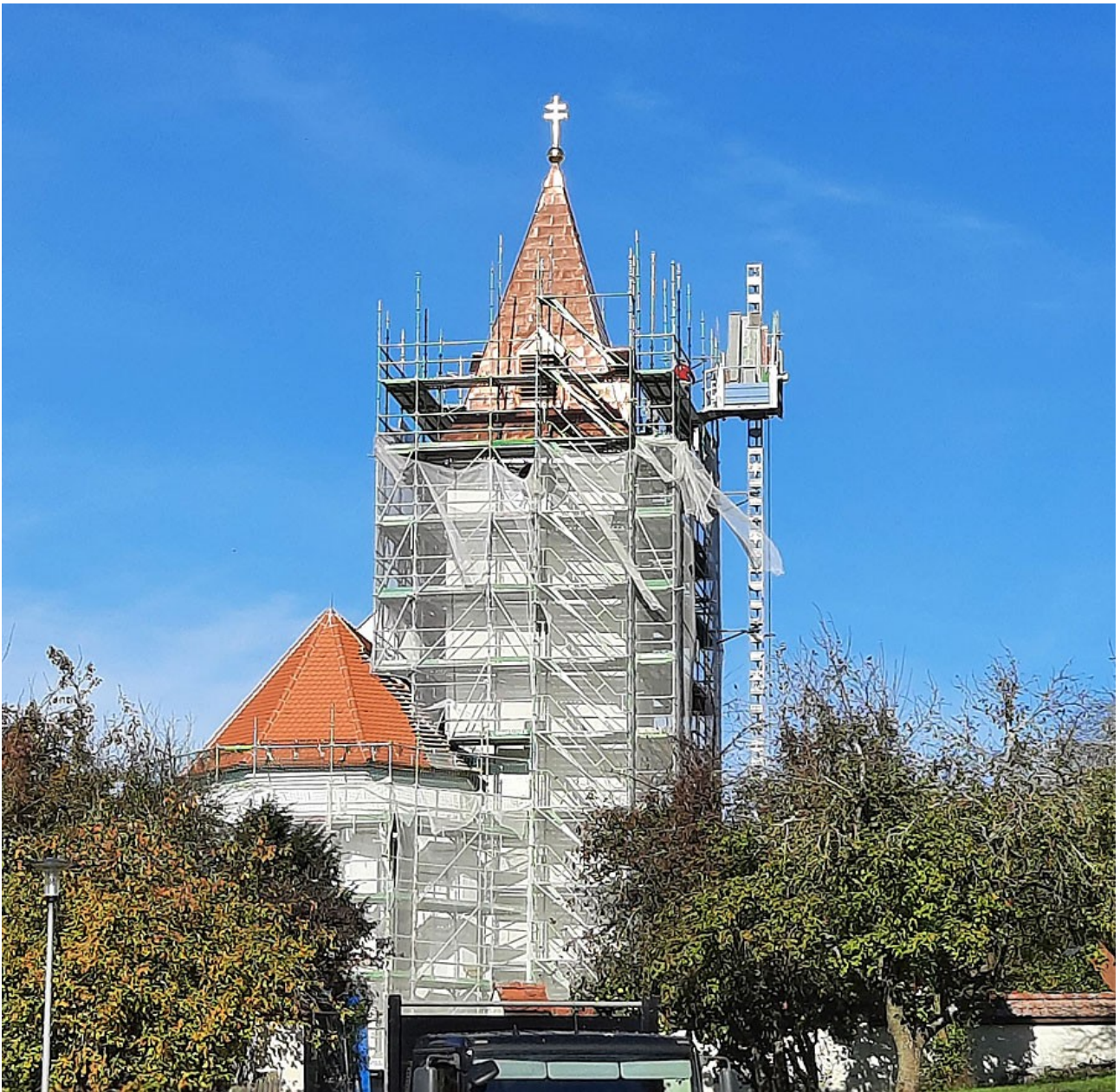
Turm von Hütgasse aus gesehen, Oktober 2021
